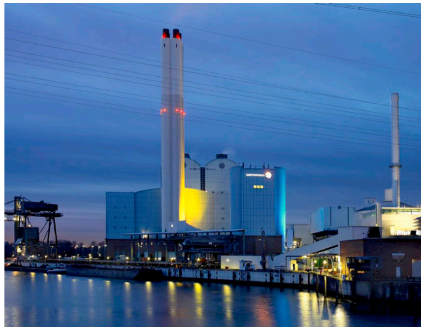
Das Heizkraftwerk Tiefstack in Hamburg arbeitet nach dem Prinzip der Kraft-Wärme-Kopplung
